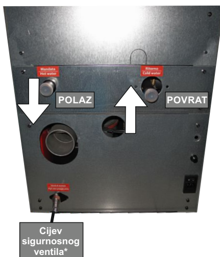
Slika 5. Polaz, povrat i cijev sigurnosnoga ventila
